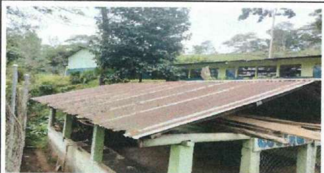
Foto 4: TECHO DE LA COCINA A SUSTITUIR
