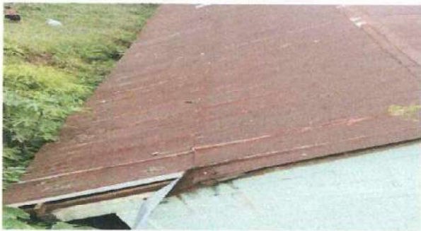
Foto1: TECHO DE LAS AULAS A SUSTITUIR
