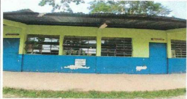
Foto 2: PARTE FRONTAL DEL TECHO DE LAS AULAS A SUSTITUIR
