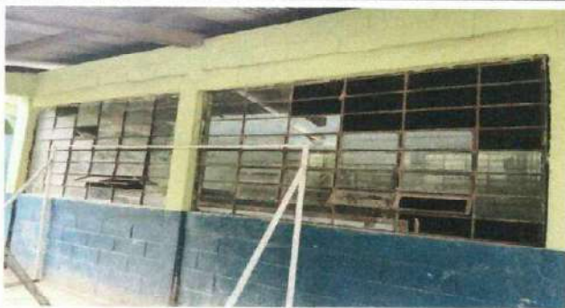
Foto 3: VENTANALES DE LAS AULAS A SUSTITUIR
